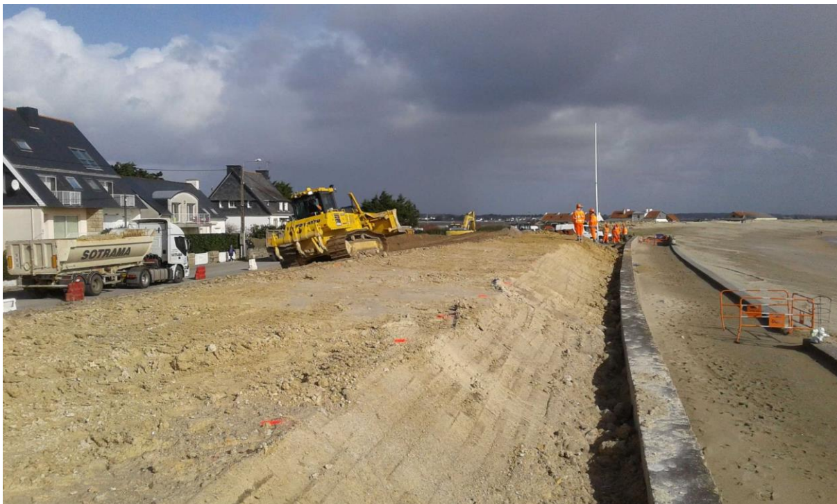
Figure 33 Mise en place du noyau de kaolin sur la dune du Boulevard de l'Océan, le 17 février 2020
