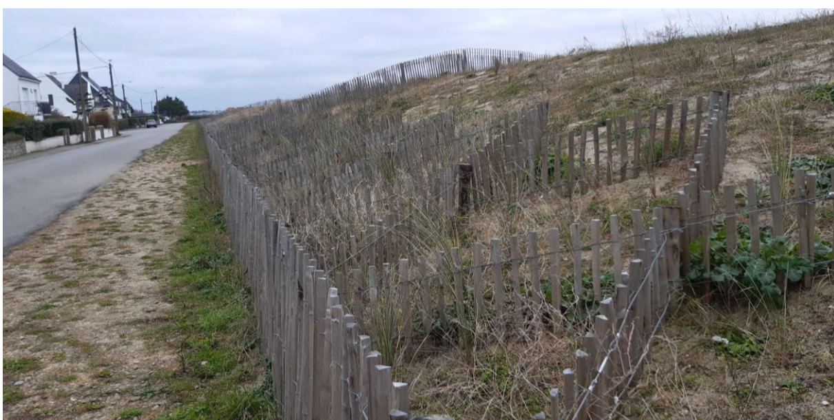
Figure 12 La dune reconstituée Boulevard de l'Océan, 1 an après les travaux, le 19 janvier 2021
