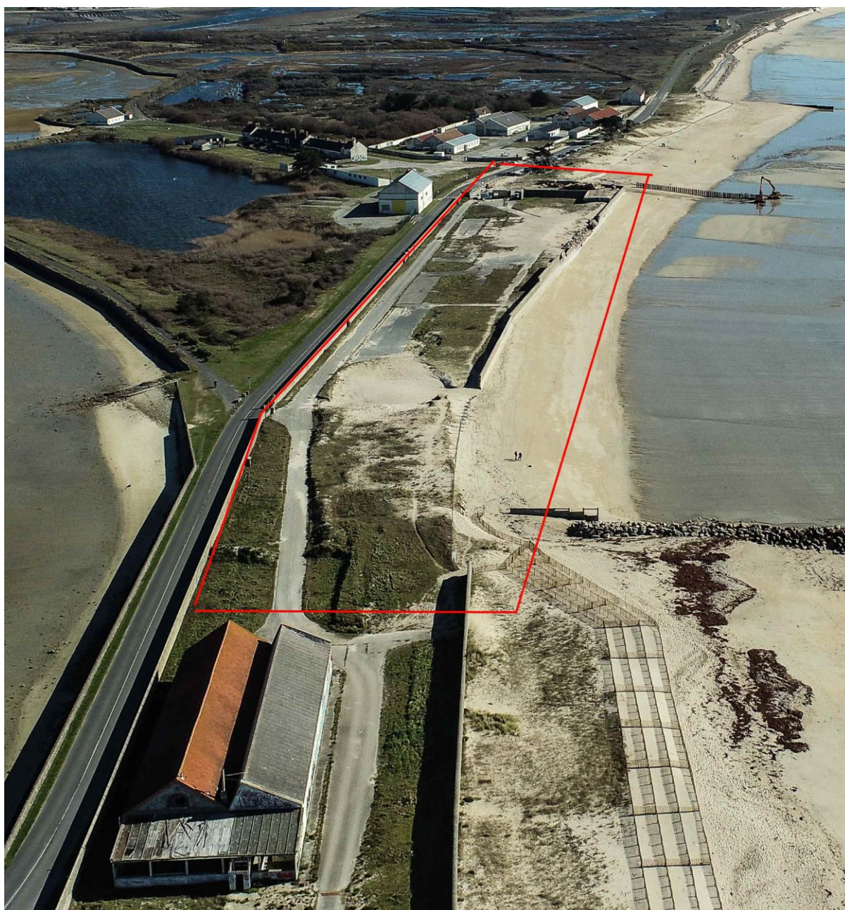
Figure 9 Photo aérienne du site le 27 février 2021, avec matérialisation du périmètre du projet
