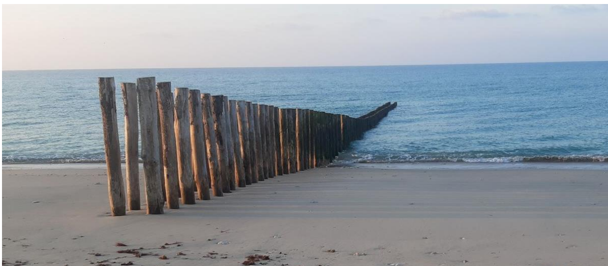
Figure 10 Epi en rondins à proximité de la pyrotechnie, le 4 octobre 2024
