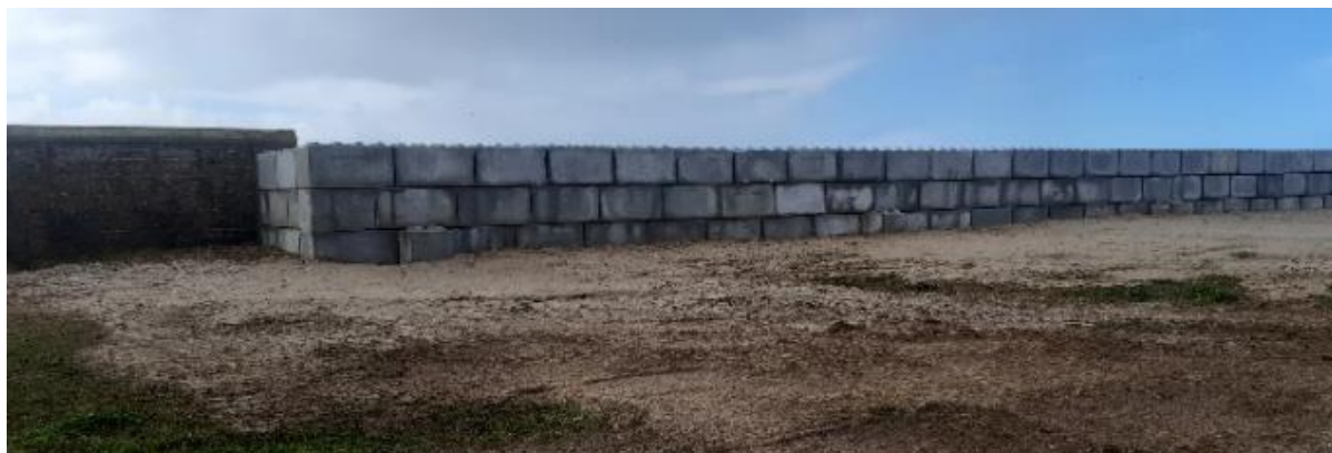
Figure 14 Ouvrage temporaire mis en place à l'hiver 2023/2024
