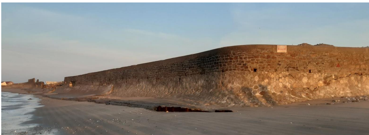
Figure 6 Le mur d'enceinte côté mer, le 4 octobre 2024
