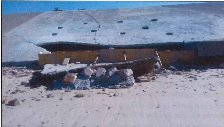
Figure 9 : Coffrage et position des injections le 23 février 2018 (Source : Commune de Gâvres)
