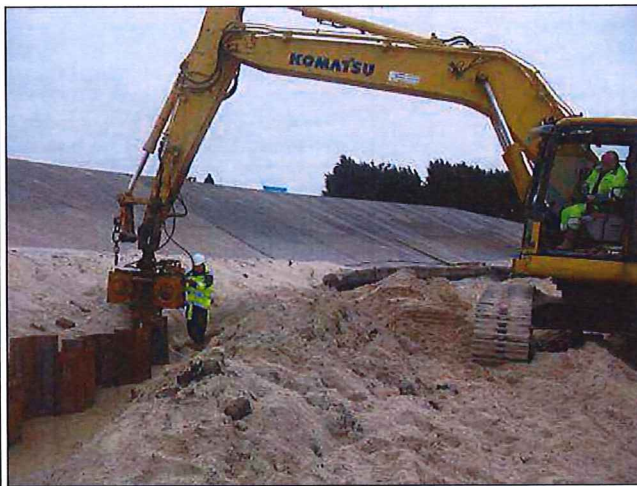
Mise en œuvre du rideau de palplanches devant l'existant
