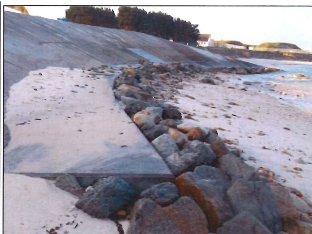
État de l'ouvrage après coulage du béton et pose d'enrochements
