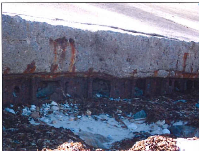
État du pied de perré au nord de la cale avant travaux
