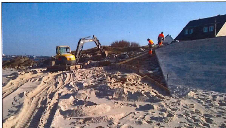
Figure 7 : Travaux réalisés en mars 2016 (Source : Commune de Gâvres)
