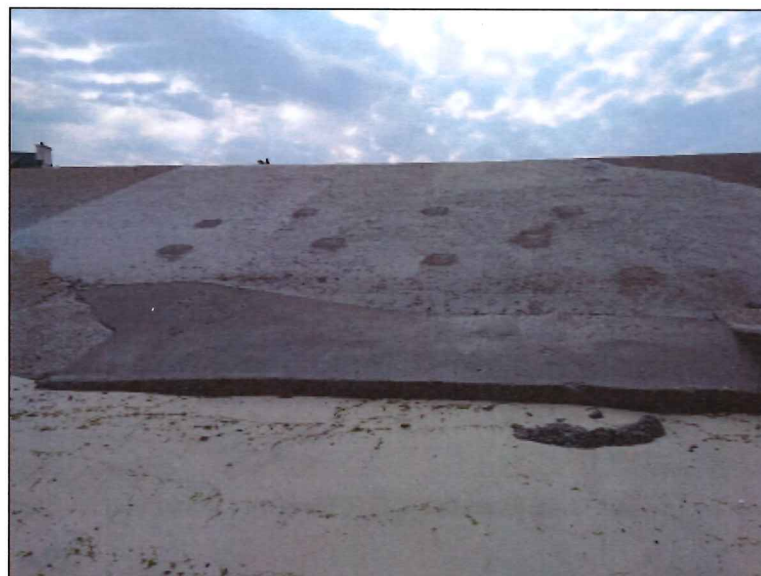
Figure 10 : État des réparations au 16 mai 2018 (Source : Arcadis)
