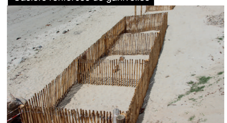
Casiers renforcés de ganivelles
