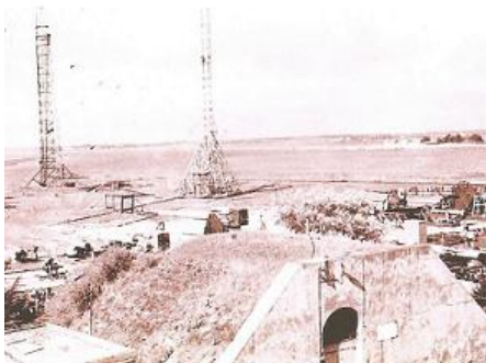
Pylônes et abri de Kersahu
