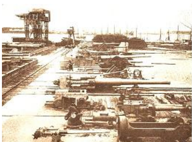
La batterie de Kersahu en 1930 (L .Patard)
